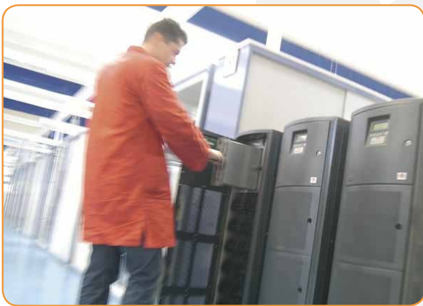
Batteriskifte på UPS-anlæg. Foto: Scanpocon.
