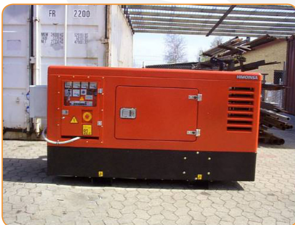
30 kVA generatoranlæg til brug ved montage af havvindmøller. Foto: Scandinavian Engineering Systems A/S.
