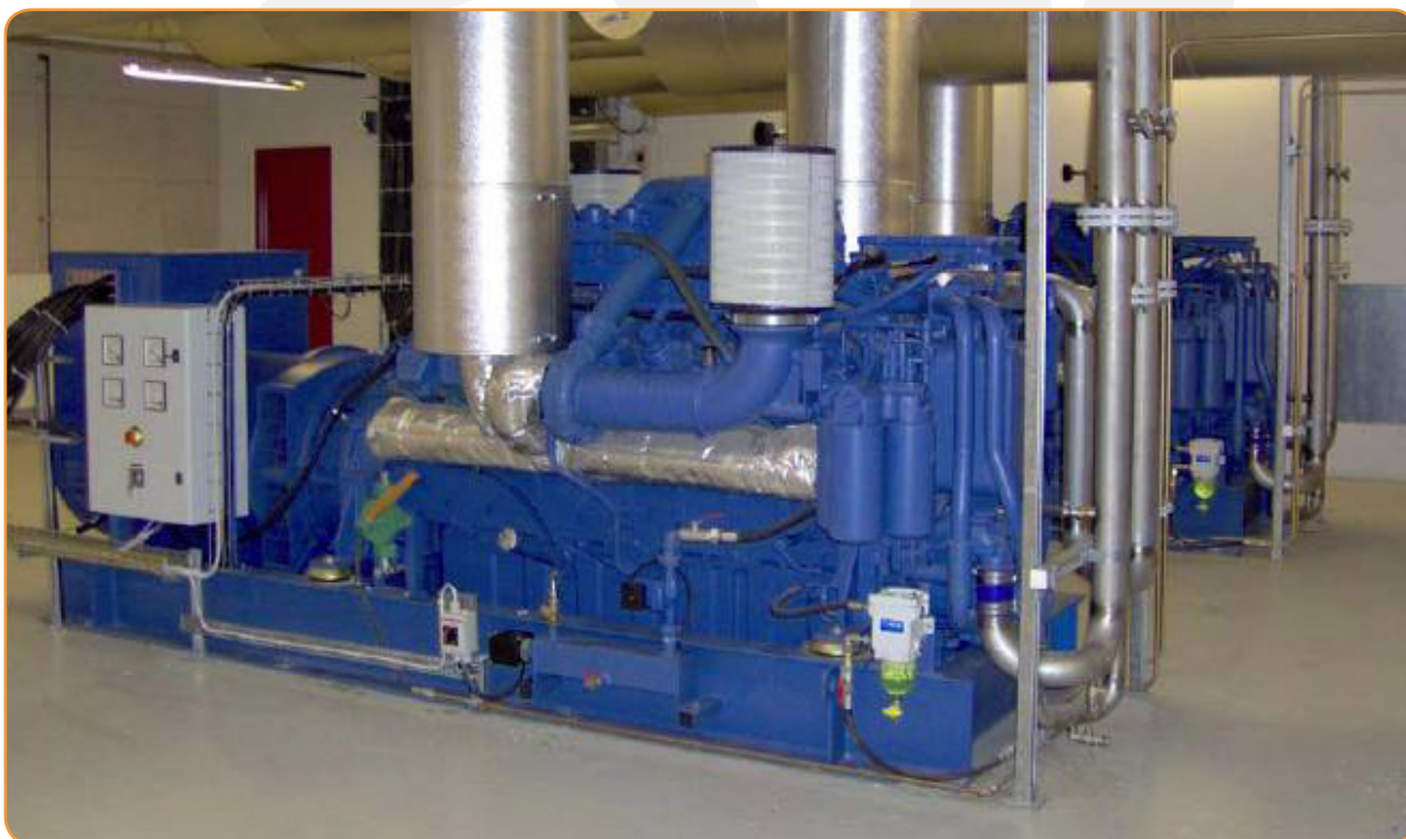
2 x 1.000 kVA nødgeneratoranlæg hos DONG Energy. Foto: Scandinavian Engineering Systems A/S.
