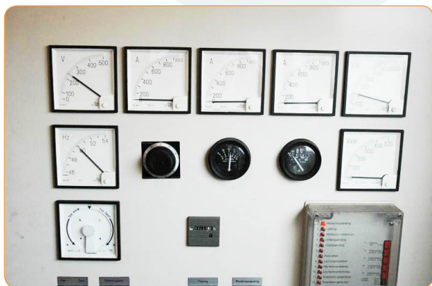
Instrumenter fra et nødstrømsanlæg.
