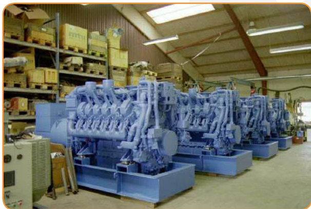
4 x 1.400 kVA nødgeneratoranlæg, DR Byen. Foto: Scandinavian Engineering Systems A/S.
